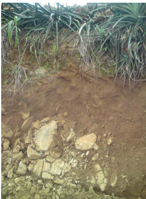
Foto # 3 Perfil de meteorización típico de la colada Abarca, se observa que la roca madre se encuentre a menos de un metro de la superficie, coordenadas 569740 Este y 239404 Norte
