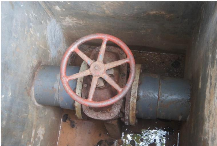
Fotografía: Válvula de compuerta
