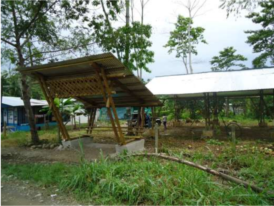
Parada de bus y salón Multiuso en Miramar, ASOMUCABALI.
