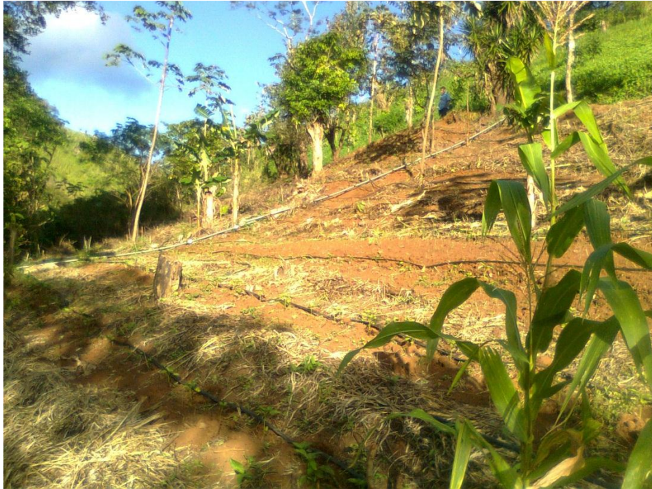
Instalación de sistema de riego por goteo. 28 noviembre 2011. Cerro Negro
